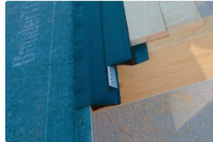
AERO-PAN ist ab einer Dachneigung von 17° einsetzbar. AERO-PAN wird einfach in die Dachschalung integriert.
