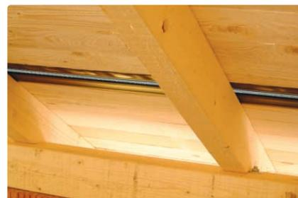
Der gelochte Steg von AERO-PAN ermöglicht die Luftzirkulation, verhindert jedoch das Eindringen von Kleintieren wie Siebenschläfer, Mäusen, usw.
