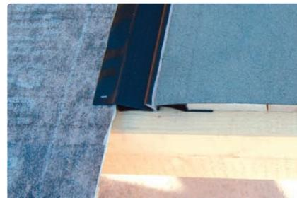
Die Vordeckbahn wird im traufseitigen Bereich unter das AERO-PAN gezogen und im oberen Bereich auf das AERO-PAN aufgelegt bzw. geklebt.
